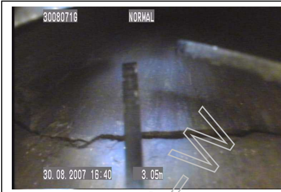
Nr. 2 Beschädigung Innenrohr: 3,05 m von dem oberen Reinigungsverschluss nach unten aus gesehen
