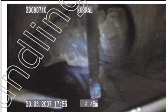
Nr. 3 Beschädigung des Innenrohres beim Abgasrohranschluss 4,45 m von dem oberen Reinigungsverschluss nach unten aus gesehen
